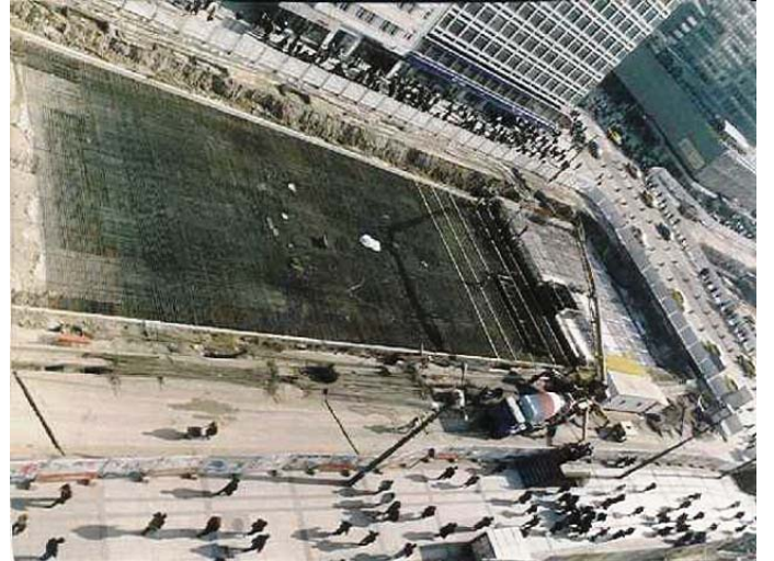
Şekil 8: Üst kat döşeme demir montajı
