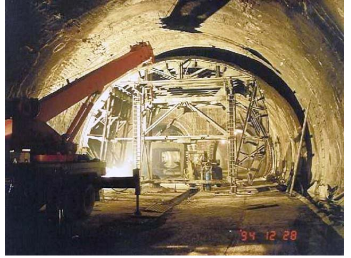
Şekil 24: Betonlama çalışması
