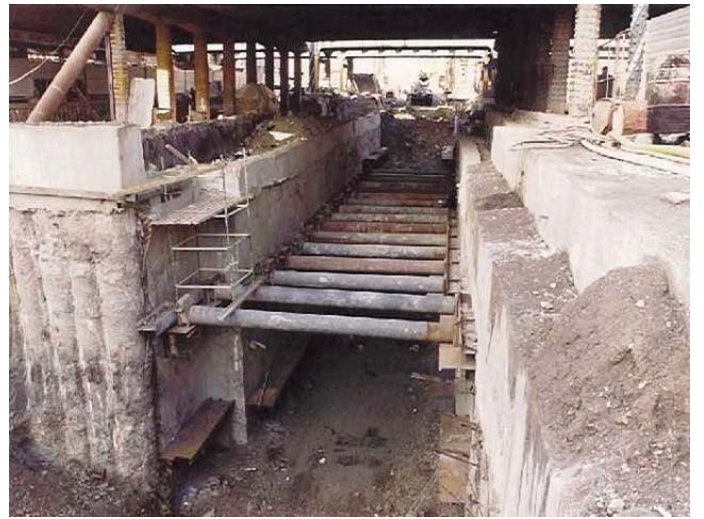
Şekil 34: Sıhhiye köprü altı geçişi
