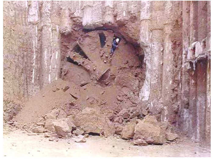
Şekil 23: Tünel delme işlemi ve istasyona giriş
