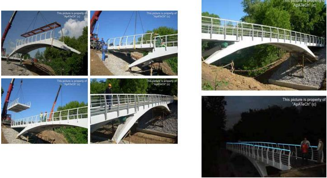
Şekil 20: Vakum infüzyon yöntemi ile üretilen ilk FRP kompozit köprü
