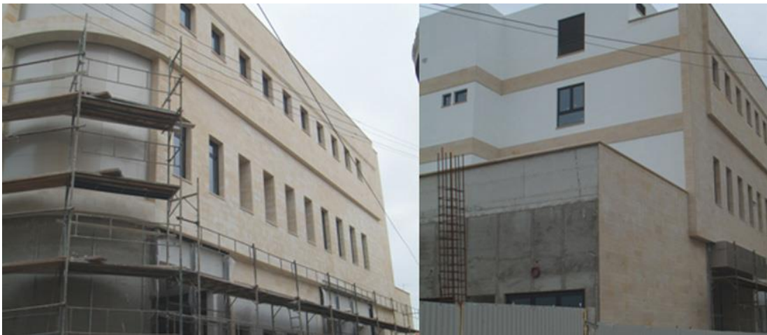
Telekominikasyon Binası, Kıbrıs; Kolon, kiriş ve döşemelerin, statik ve dinamik güçlere karşı 3-4 kat güçlendirilmesi
