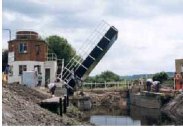
Şekil 13: 1994 yılında inşa edilen GFRP aç-kapa köprüsü
