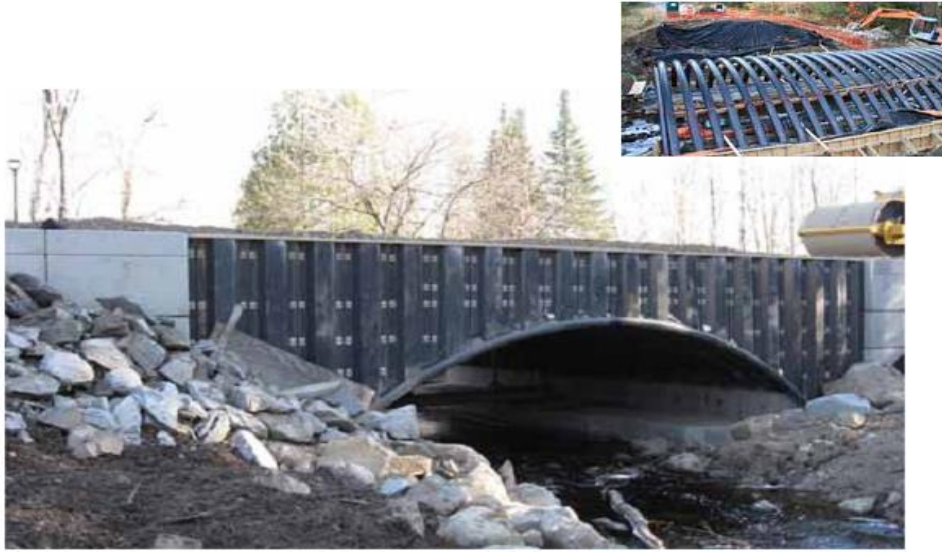
Açıklık (11m x 13m) inşaat 3 günde tamamlanmıştır.
