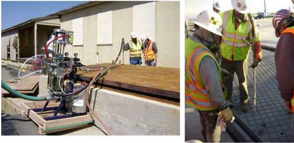
Şekil 23: GFRP ile ilk karayolu uygulaması
