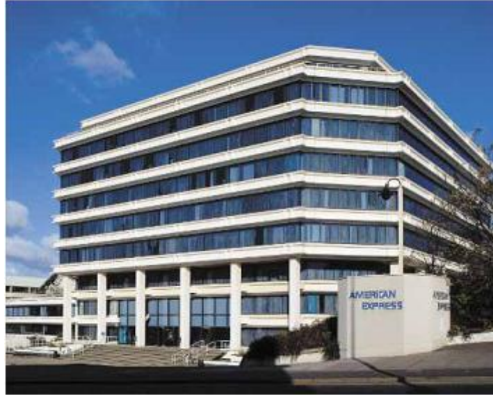
Şekil 8: American Express Binası, taşıyıcı sisteminde GFRP kompozitler kullanılmıştır
