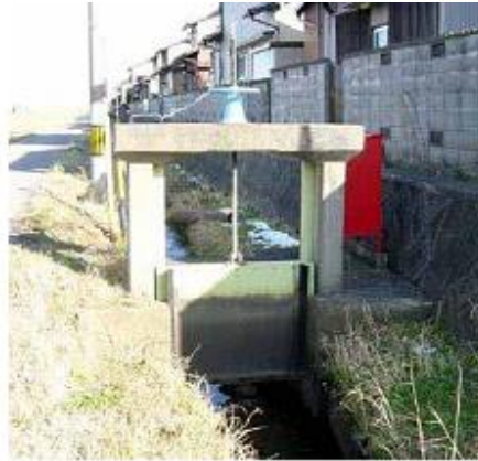
Şekil 6: 35 yıldır kullanılmakta olan bir GFRP kapak, Japonya
