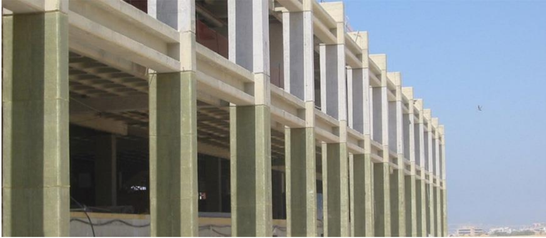
Olimpiyat Stadyumu, Atina; Kolon ve kirişlerin güçlendirilmesi
