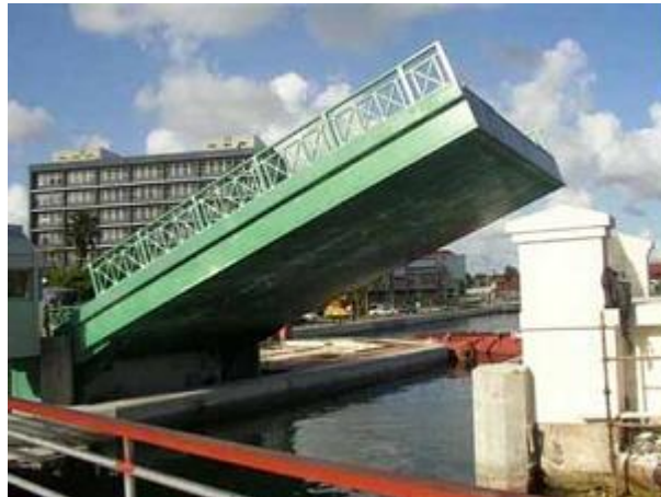
Şekil 18: 1872 yılında yapılan, korozyona uğramış çelik köprü sökülüp, FRP kompozit aç-kapa köprü yerleştirilmiştir
