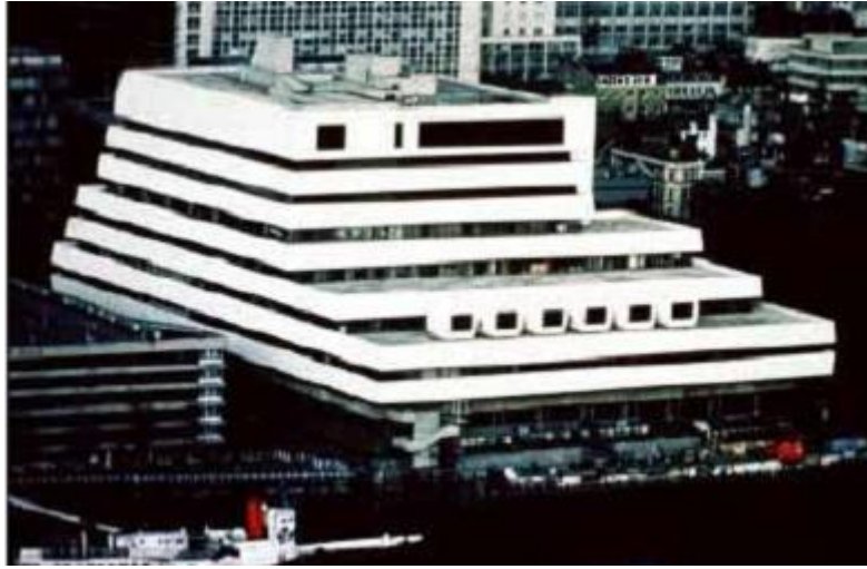
Şekil 7: 1974 Mandial House, Londra, İngiltere; betonarme iskelete FRP giydirmce yapılmış
