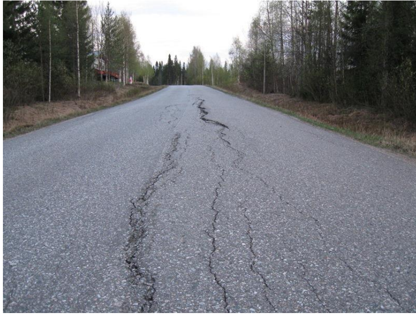
Şekil 29: Nemden etkilenmiş beton yol örneği
