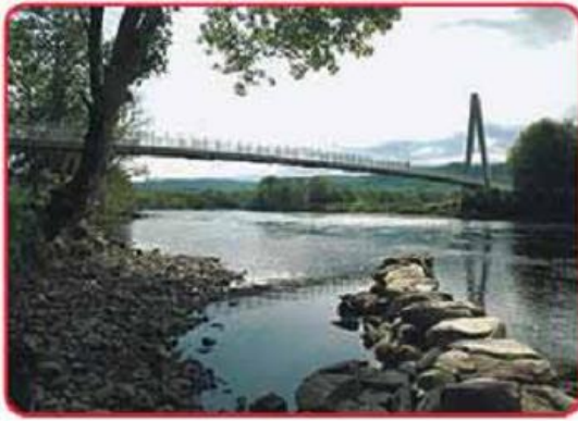
Şekil 12: En geniş açıklıklı GFRP köprü, 1992, İskoçya
