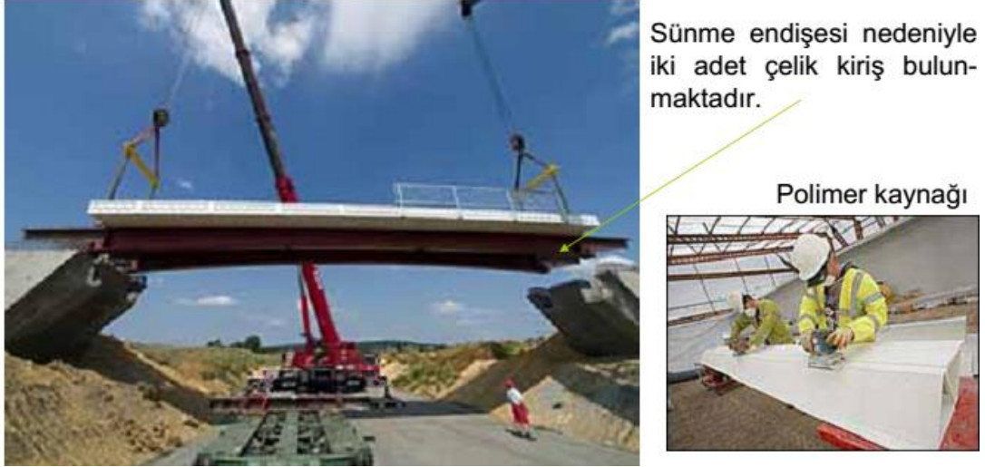
Şekil 22: Almanya'da çok hücreli GFRP tabliye ve çelik kompozit köprü
